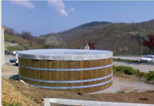
▲ Citerne en bois qui ne nécessite pas de soubassement en maçonnerie, ni d'autres installations annexes.
