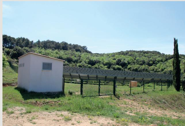
Jeu de fermeture et d'ouverture des vues par différents types de traitement des abords. A noter qu'un effort sur le design de la clôture aurait été bénéfique en optant pour une clôture en piquets bois et grillage type ursus. Cependant, en matière de réglementation relative à la prise en compte du risque feu de forêt, les Obligations Légales de Débroussaillage ne sont pas respectées avec la présence des bois.
